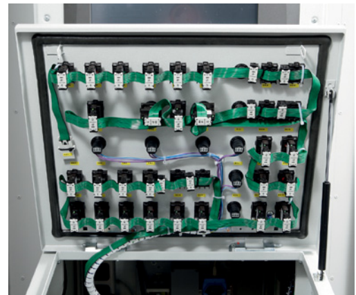
Реле easy800 с системой SmartWire-DT осуществляет управление компонентами шкафа - легко, быстро и эффективно.
