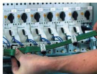
Надежная установка и электромонтаж
